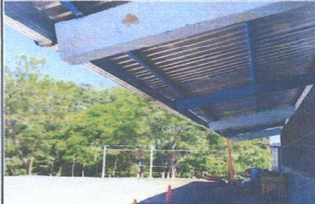
Foto 4: canales y bajadas de agua pluvial
